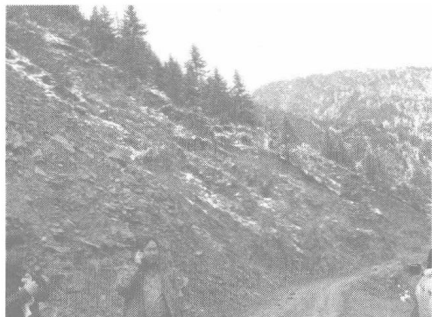
图 1.6 山坡坡脚处的公路边坡风化破碎形态
