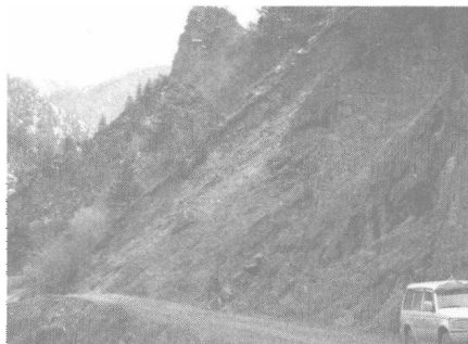
图 1.7 有部开挖后的岩质高边坡
