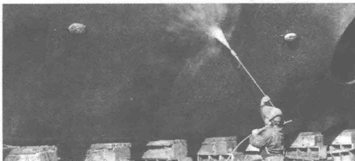
图 1-4 射流清洗作业（图片来源： http://www.directindustry.com ）
