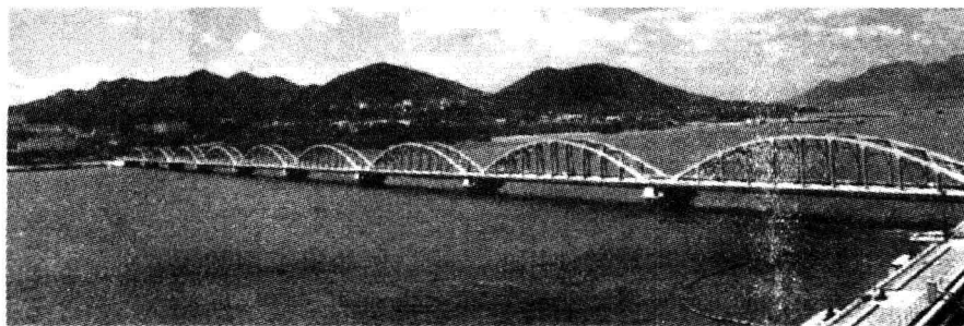
图 1.3 大连新港油码头钢栈桥
