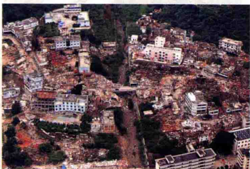
▲ 震中区鲁甸县龙头山镇房屋倒塌严重
