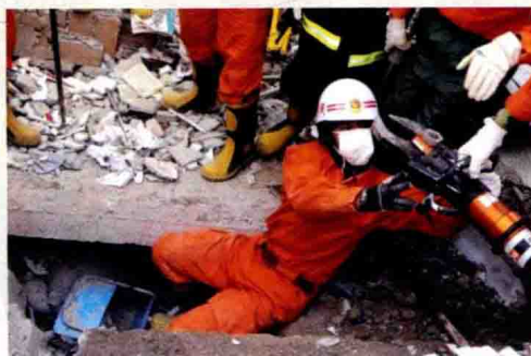
▲ 液压钳：张口咬断钢筋
