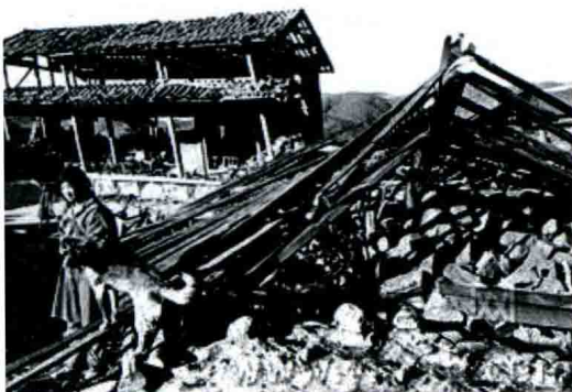
▲ 丽江地震中倒塌的房屋
