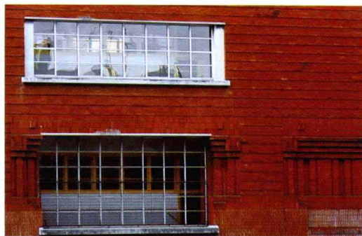
◆ 巴黎某办公建筑表皮细部。红砖的横向、纵向以及错落的排布，形成连续变化的肌理。
