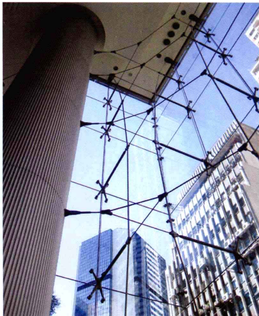
◆ 香港某办公楼建筑入口。建筑入口的挑檐被玻璃幕墙围合，玻璃墙与建筑的柱子固定，使建筑入口形成了类似大堂的空间。
