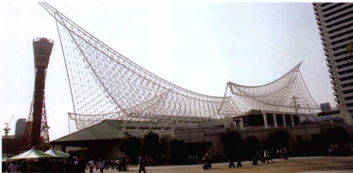
◆ 神户美利坚公园建筑。公园建筑原本的屋顶上又覆盖着装饰性的屋顶，这是几个巨大的白色网状构筑物穿插交错而成，其造型既让人联想到日本传统建筑的屋顶，又似乎有舰船外形的意向，是公园的一个标志物。
