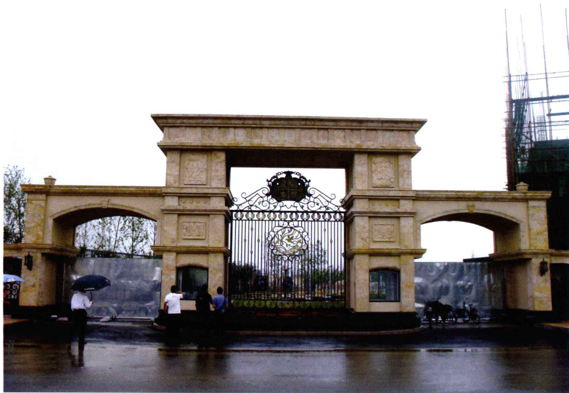
◆ 葫芦岛市某居住区大门。大门尺度大，设计形式宏伟，其造型具有很强的防御性。大门中间的门洞仅起视线通透和装饰作用，警卫室设在两侧门柱内的空间。
