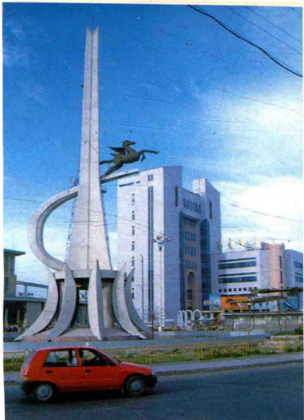
昌吉邮电大楼
