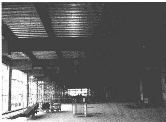
照片-1.1.1 柱 RC·梁 S 的复合结构
