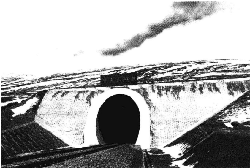
图 1-4 青藏高原铁路隧道——风火山隧道
