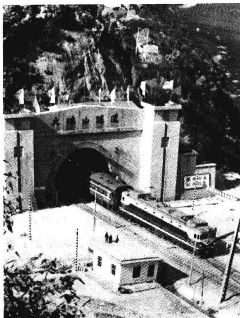
图 1-2 京广铁路复线大瑶山铁路隧道
