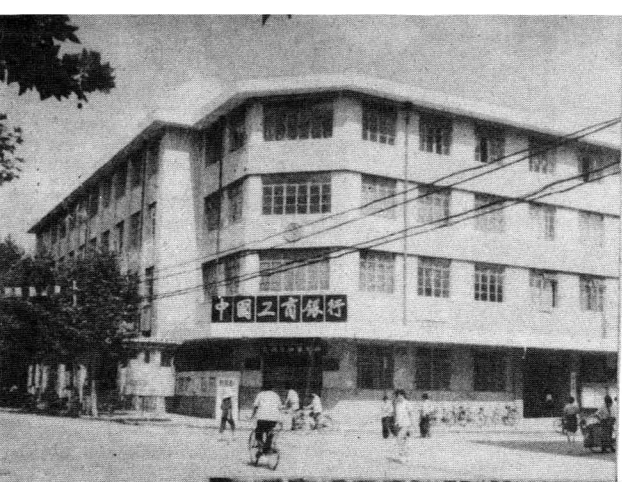
—— 办公楼 中国工商银行 江宁县支行
