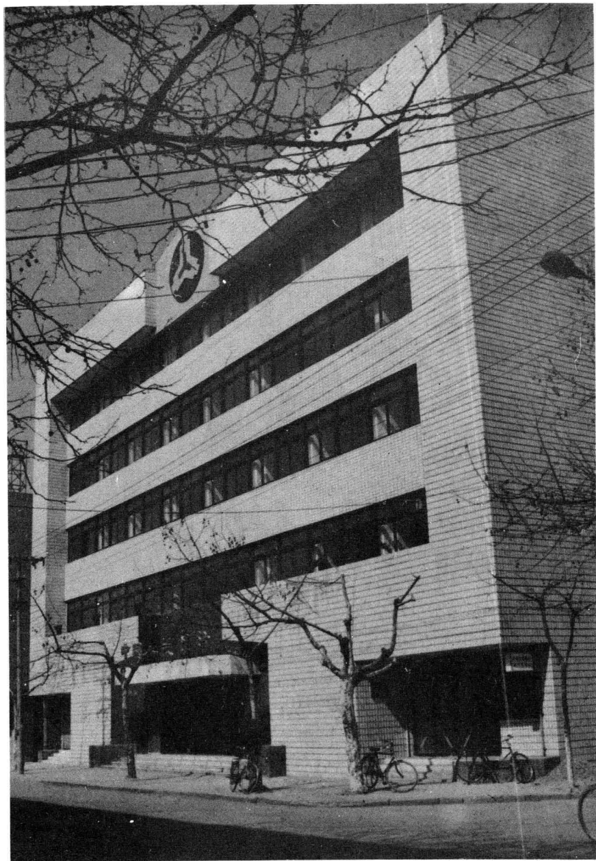
中国人民银行江宁县支行办公楼
