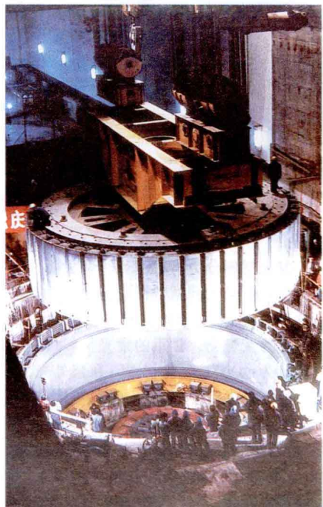
中国青海龙羊峡水电站水轮发电机吊装
