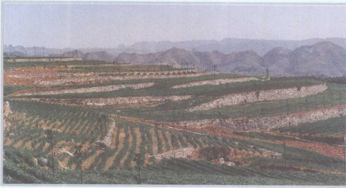
▲ 坡土改梯土工程
