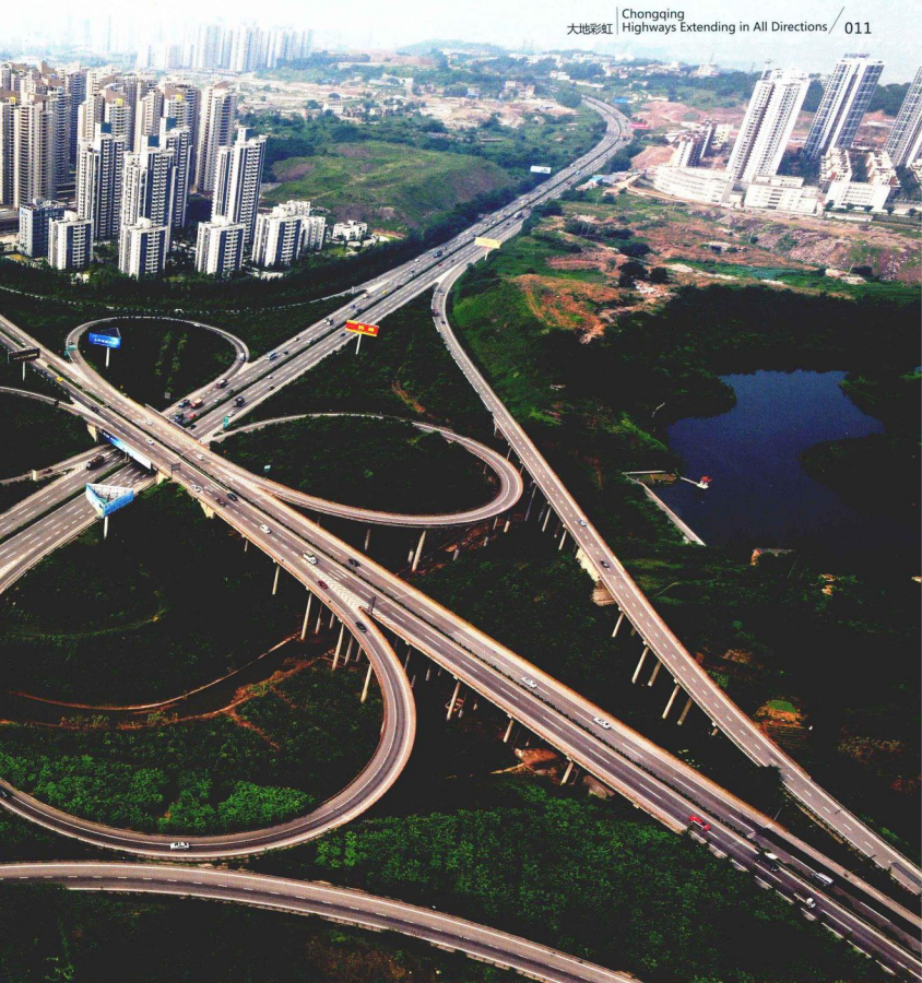
★ 重庆主城区内环高速公路，全长75公里，投资40亿元。它是重庆第一条绕城快速通道。图为内环高速公路如彩蝶卧地的北环立交。
