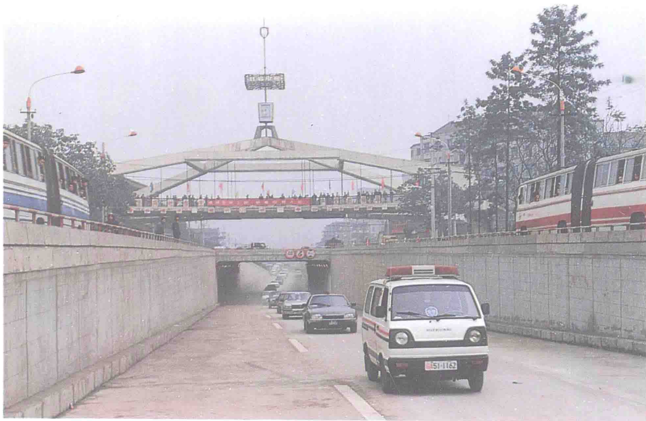
图为人行天桥和立交公路。
