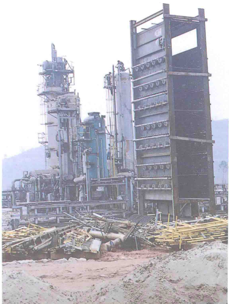
图为建设中的江北县氮肥厂引进工程。
