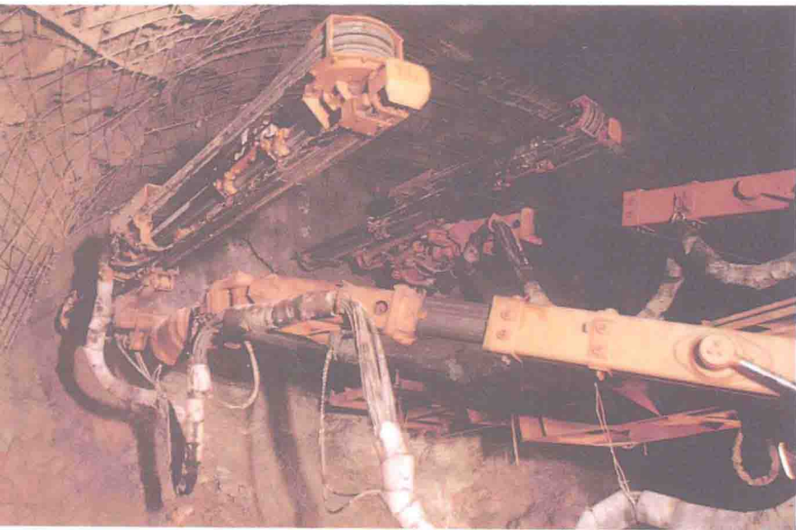
成渝公路重庆段中梁山隧道施工现场。
