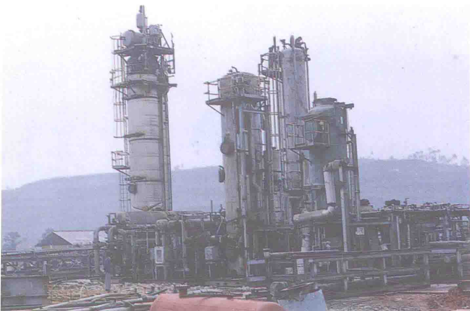
图为江北县氮肥厂引进项目主体工程。
