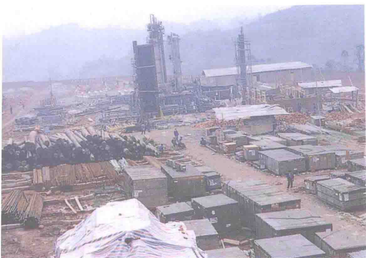
图为建设中的江北县氮肥厂引进工程。
