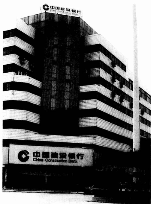
中国建设银行黔南州中心支行办公大楼 1996 年建成,位于都匀市剑江中路
