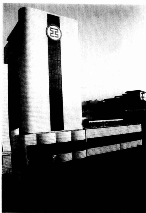
中国工商银行黔南州中心支行办公大楼 1994 年建成,位于都匀市广惠路 263 号
