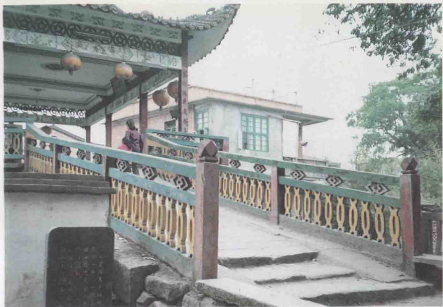
郭宅村的古桥——七星桥
