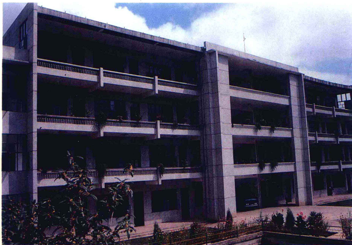
县政府办公大楼
