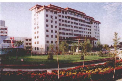
市政府办公大楼
