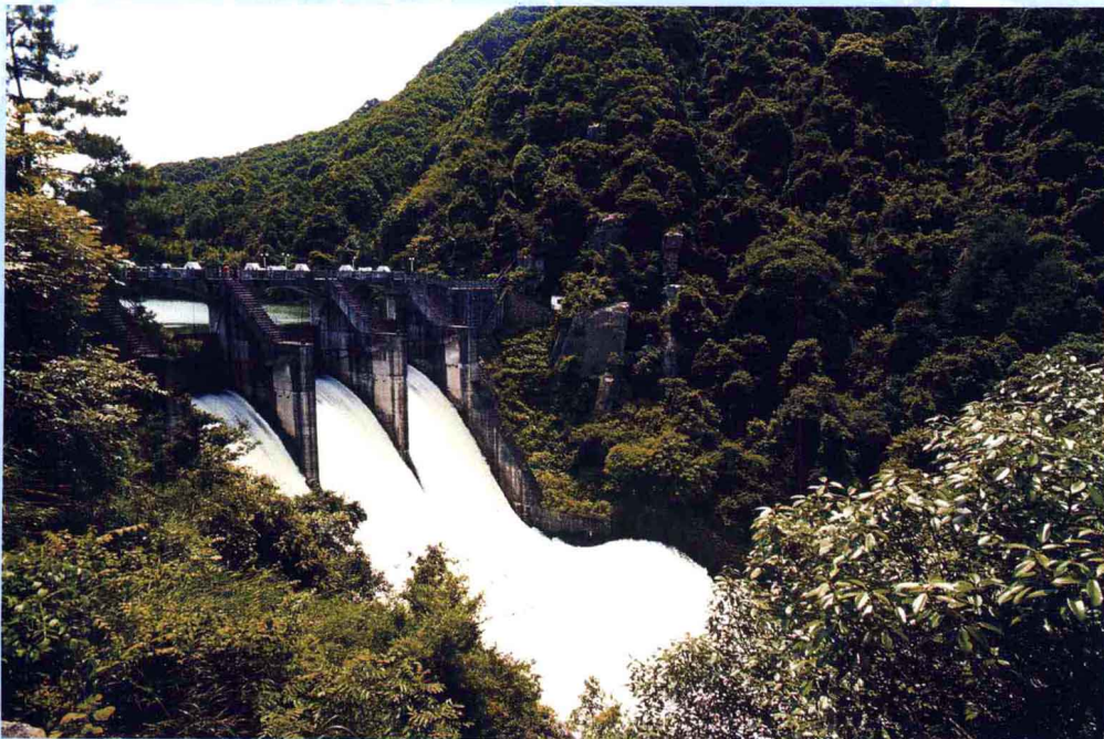
吉安市青原区白云山水库大坝
