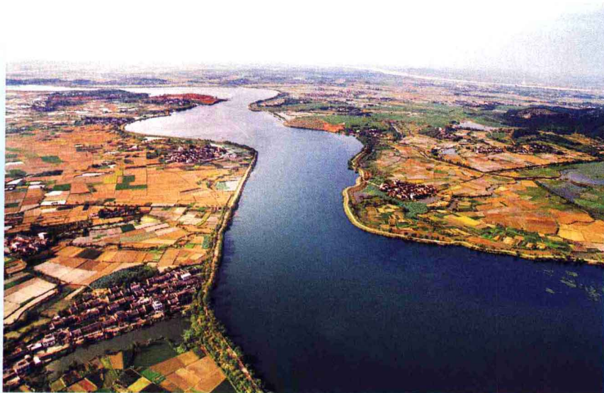
赣抚平原水利枢纽工程
