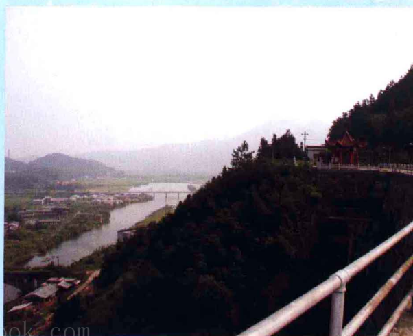
盘溪水库坝址
