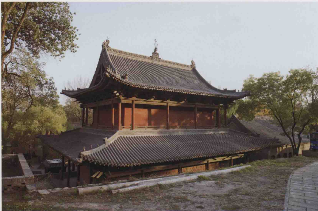
晋祠水母楼二层背立面
