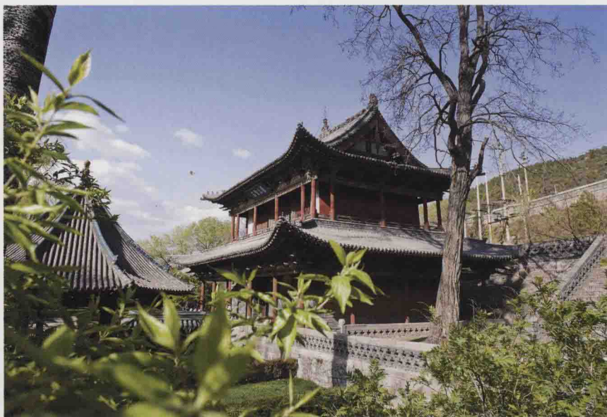
晋祠水母楼侧立面
