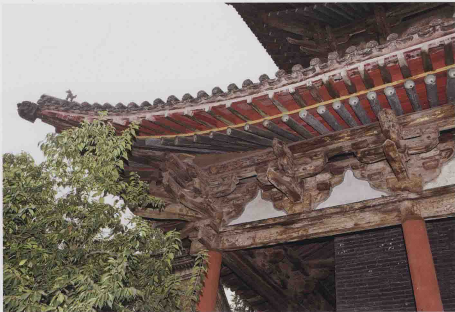
晋祠水母楼一层南侧翼角檐部
