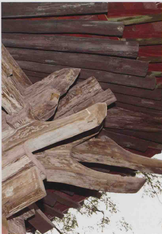
晋祠水母楼角科斗拱外跳
