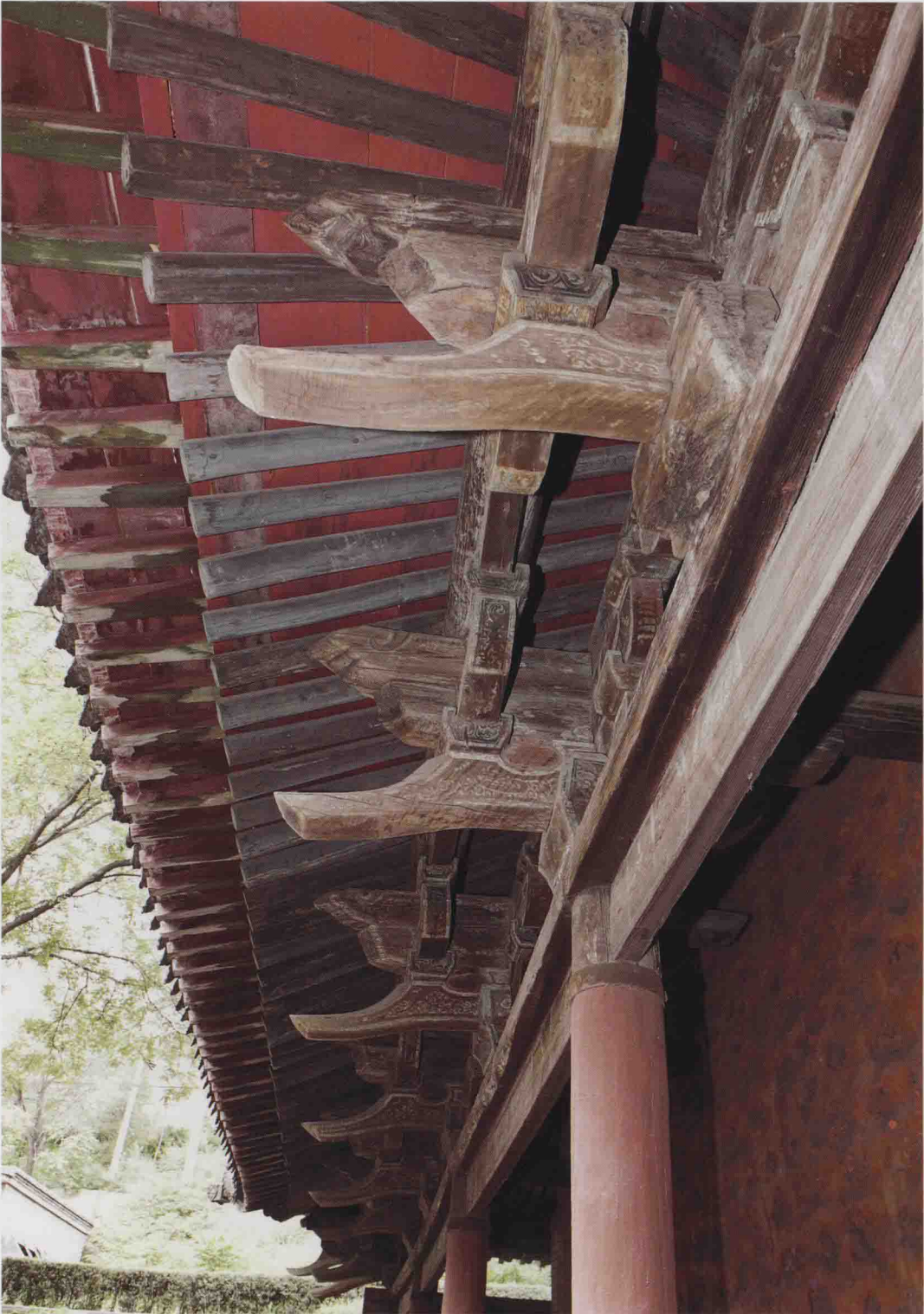
晋祠水母楼一层檐下斗拱
