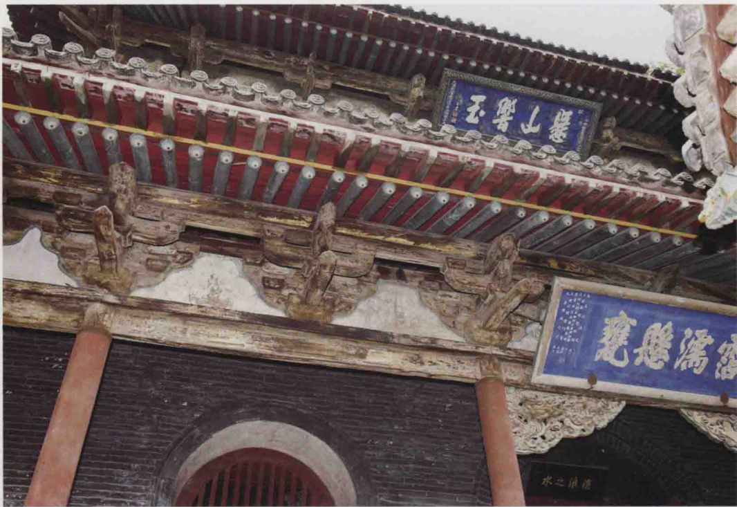
晋祠水母楼一层檐部
