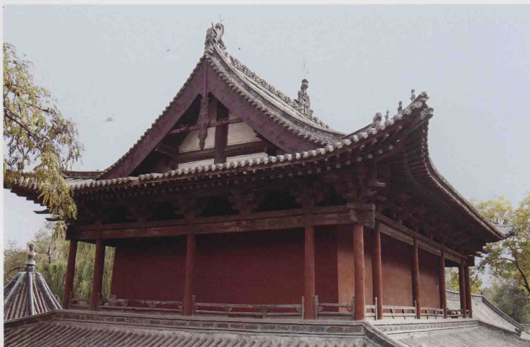
晋祠水母楼二层北侧立面
