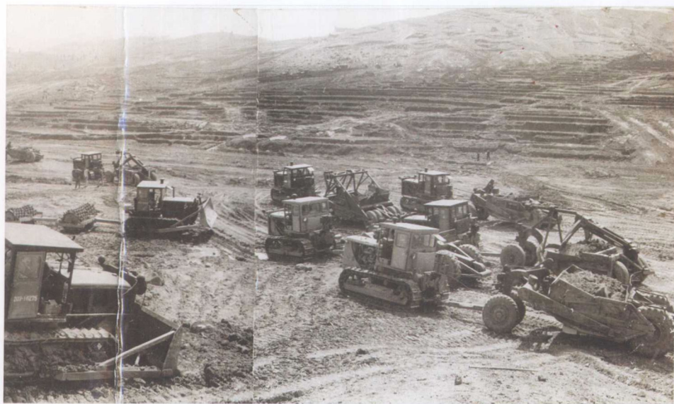
▲川维厂地平场
