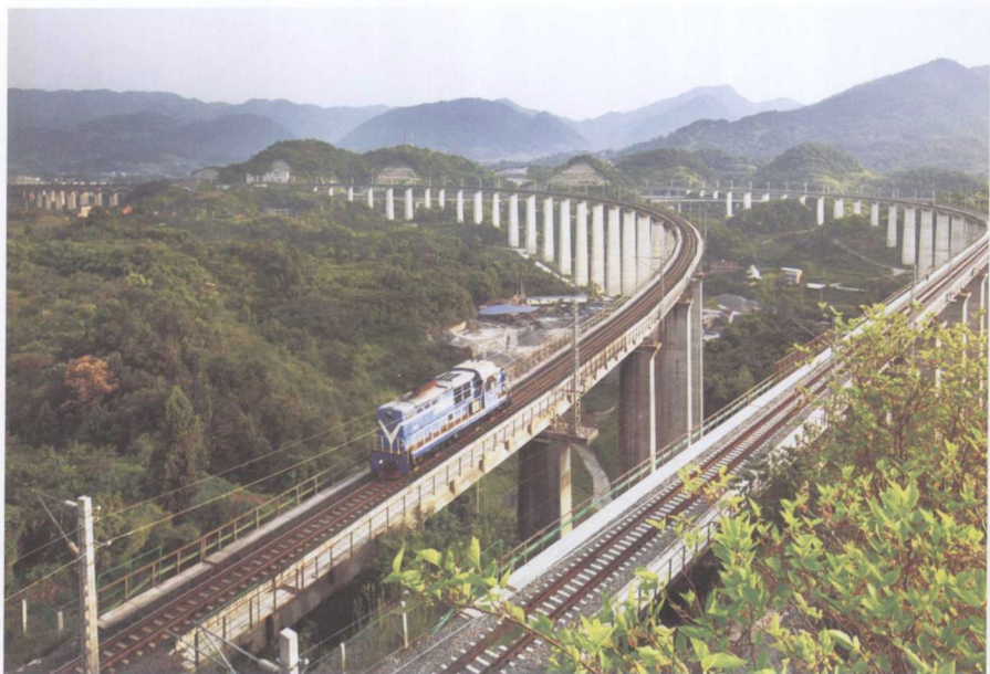
▲重钢专用铁路
