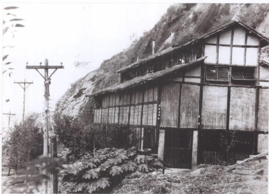
▲1939年4月开工,1940年4月竣工的羊角堡煤气发电所全景
