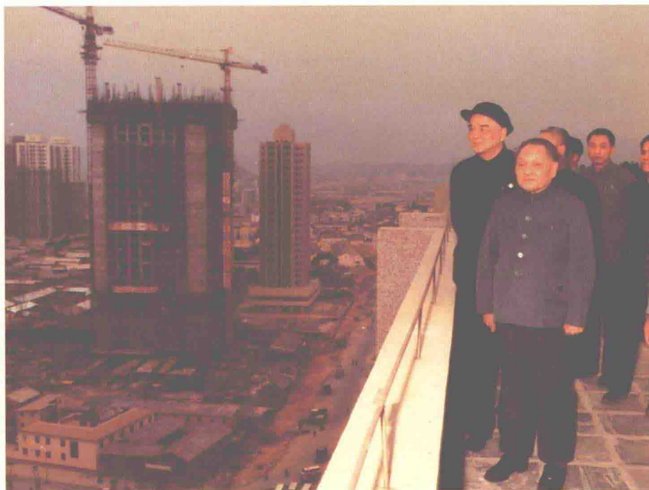
1984 年梁灵光陪同邓小平在深圳国商大厦楼顶参观。
