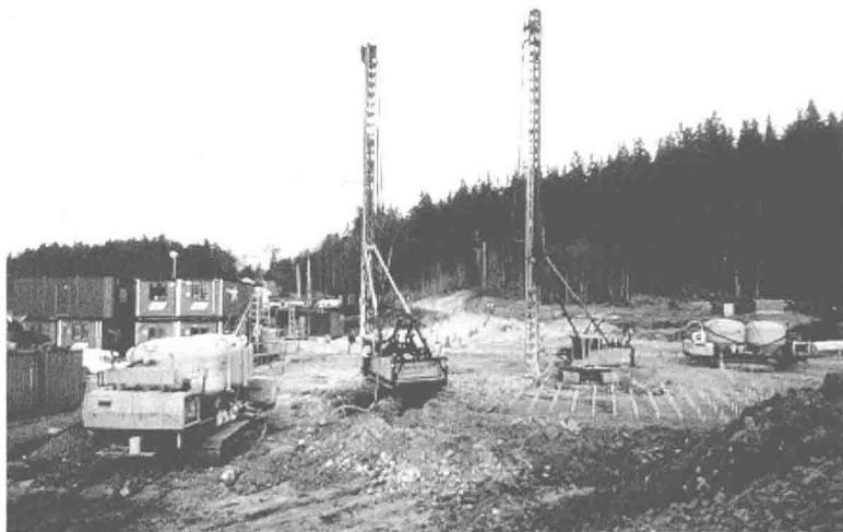
图 1-1 北欧地区最常用的粉喷桩施工机械(Holm G., 2003)
