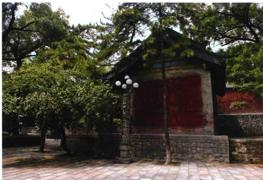
晋祠贞观宝翰亭东侧正立面
