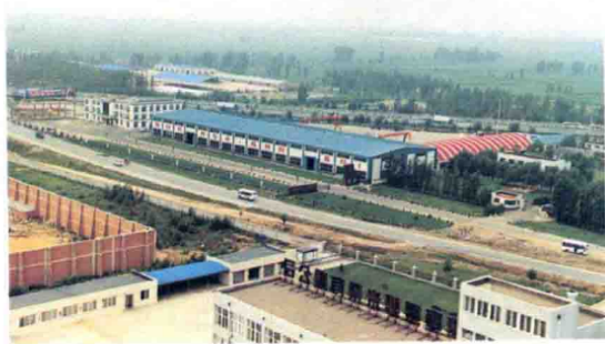
工业园区生机无限
