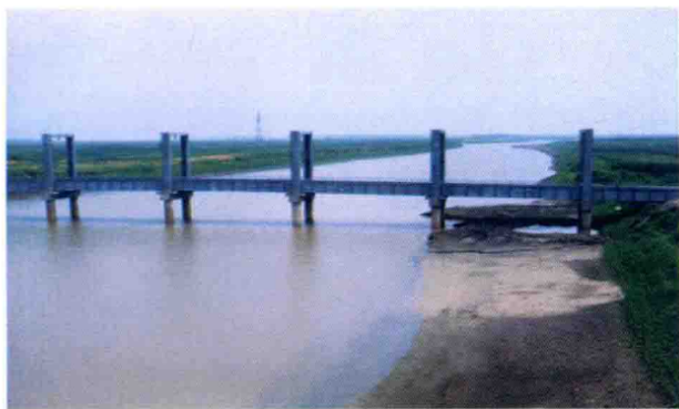
新华境内的跨河铁桥
