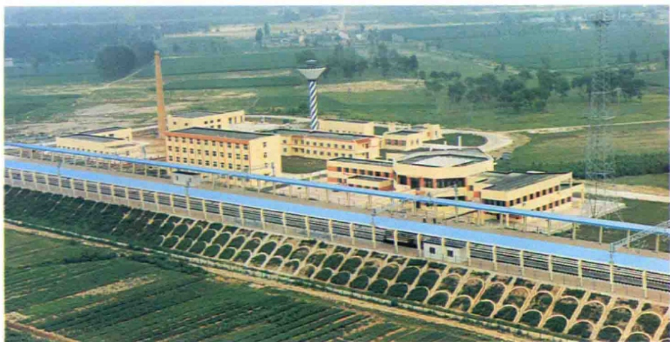
秦沈高速电气化铁路台安站
