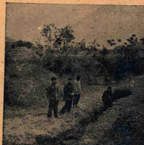
已計劃綜合治理。圖為勘察隊在溪，
