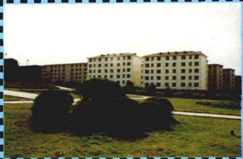
城镇住宅小区
