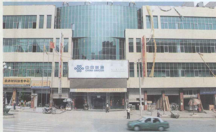
铜仁地区联通分公司办公大楼(顶楼)
