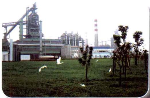
炼铁新厂大高炉
