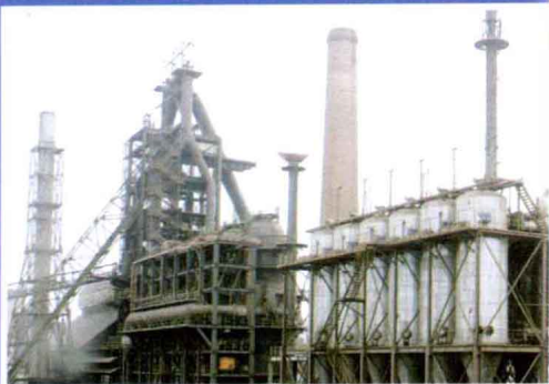
高炉煤气干法除尘设备
