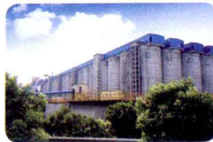
总容量64万吨的储煤筒仓
