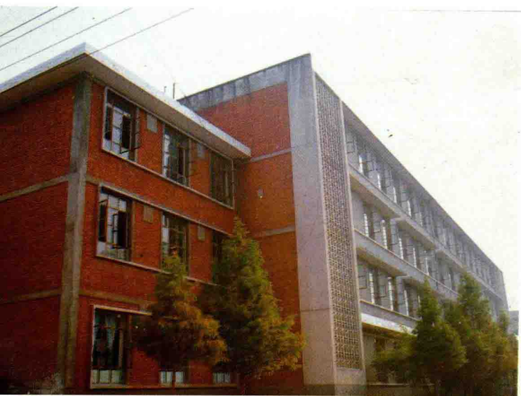
◀ 汉阴中学教学大楼
