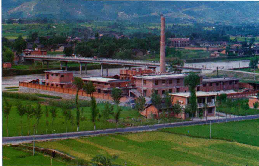
建设中的蒲溪土霉素钙盐厂 ▶
