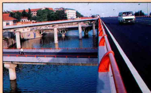
廈門大橋集美立交橋
