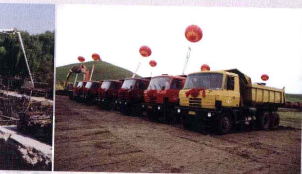
土方工程运输车
