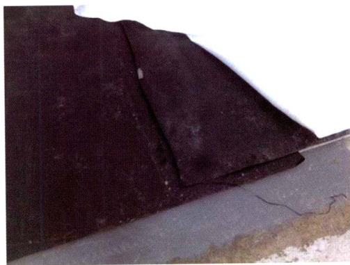
图 3.2.1—6 土工膜搭接不符合要求
