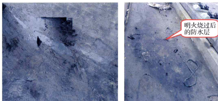
图 3.2.1—2 防水层破损
