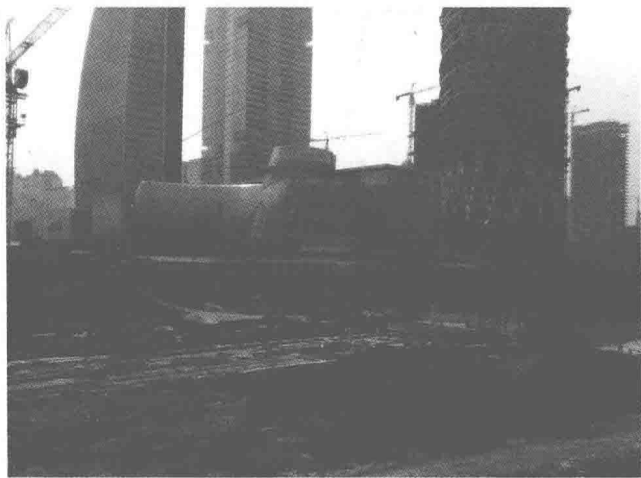
图 1-2 珠江新城高德置地广场项目基坑施工现场
