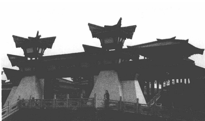
位于今山东临淄的管仲纪念馆
