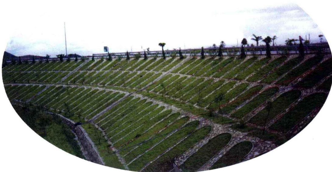
路堤边坡的三层拱式防护。既省材料，又美化环境
