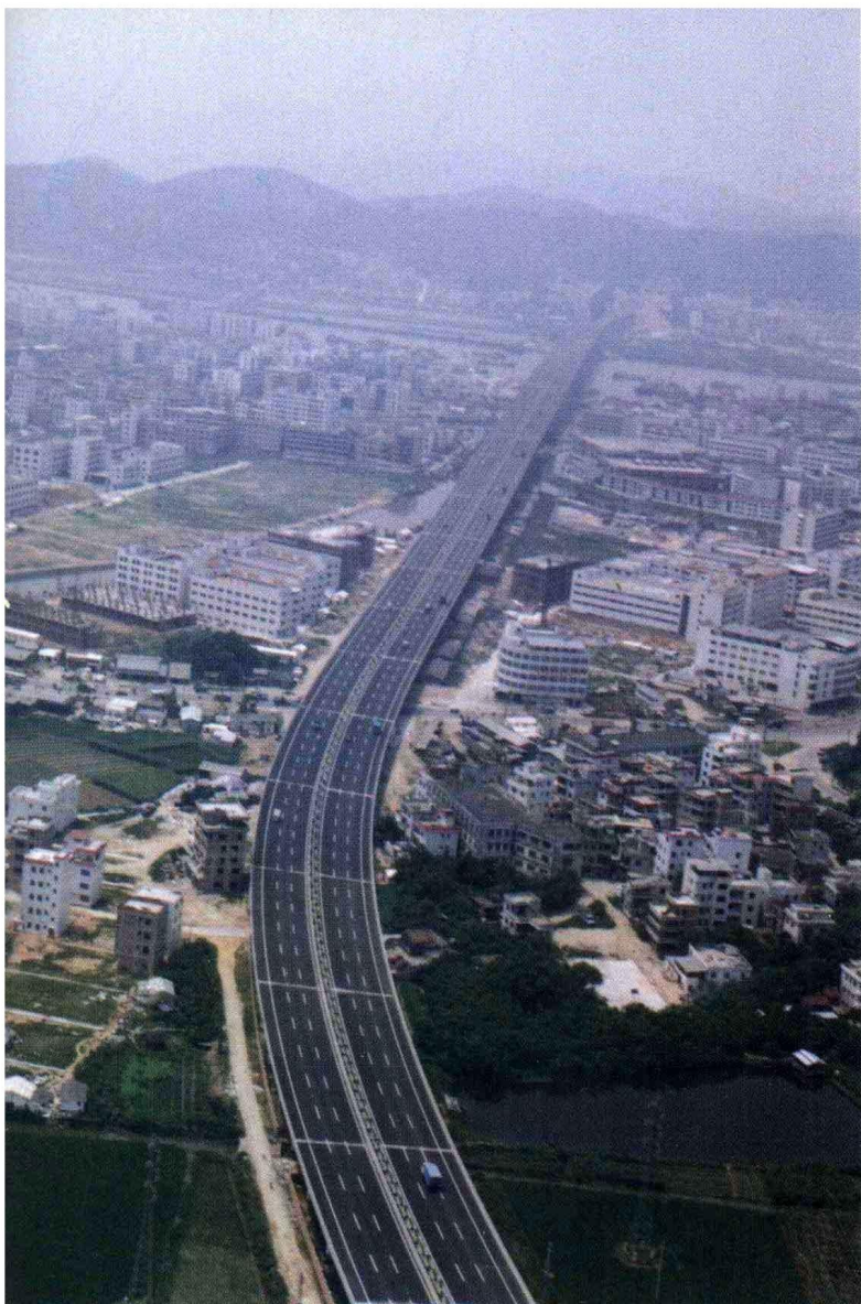
太平大桥鸟瞰(航摄), 全长左 线 2 833.5m, 右线 2 776.5m, 穿越 虎门镇, 跨越太平水道
