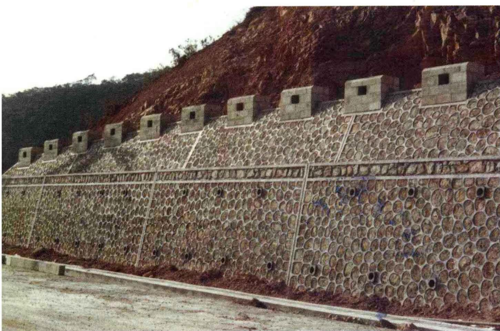
威远山路堑挡土墙，采用带炮口符号的嵌入式墙帽
