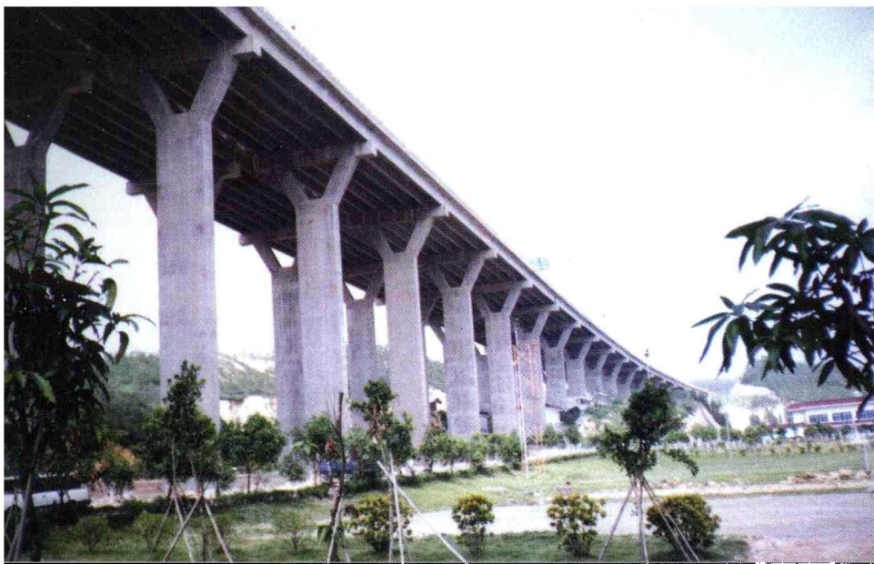
大石吓高架桥，22 × 30m特大桥，带Y型墩的预应力混凝土连续刚构桥
