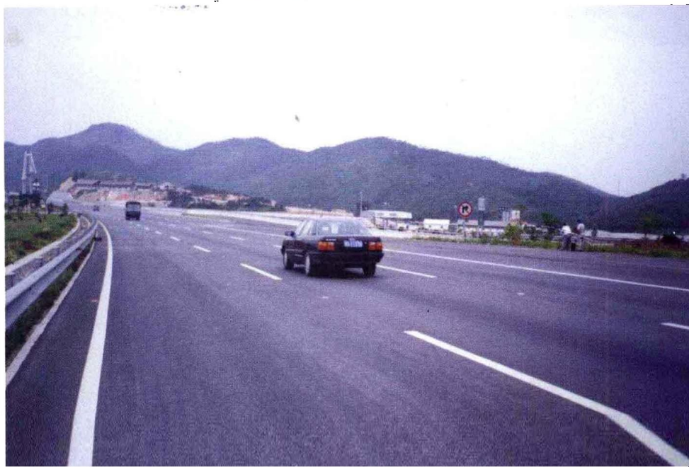
复合式路面，24cm 碾压式混凝土路面。上铺 5cm中粒式SBR改性沥青 混凝土面层
