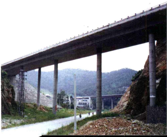
南面村2号桥，6孔，跨径20-24.4m，中墩为独柱墩，钢筋混凝土连续刚构
