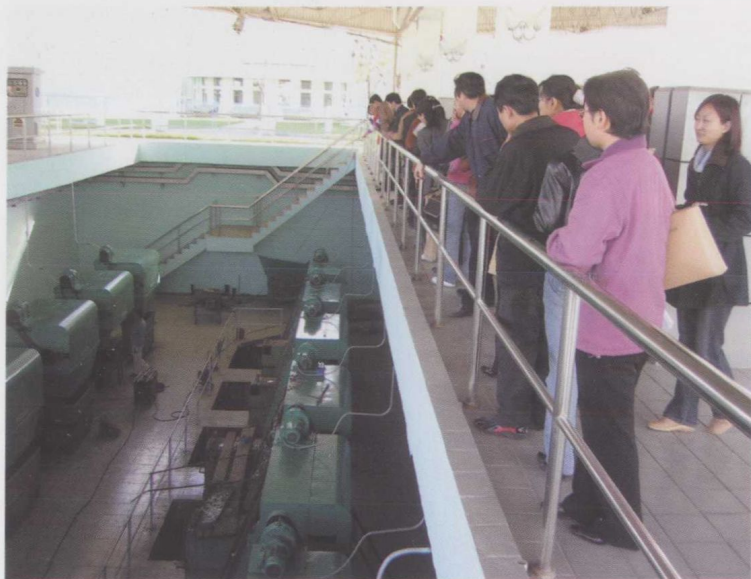
参观北京最大的污水处理厂——高碑店污水处理厂。
