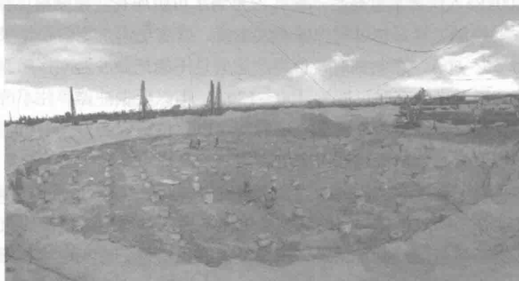
图 2-2 石灰桩法处理软土地基
