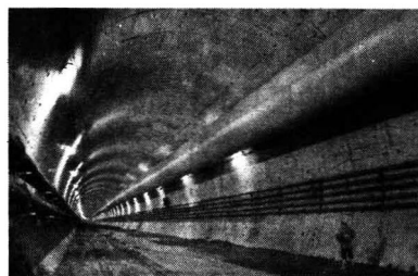
图 2-2 混凝土管片隧道衬砌
