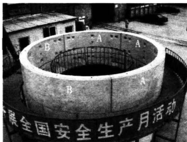
图 2-4 钢筋混凝土管片拼装成管环
