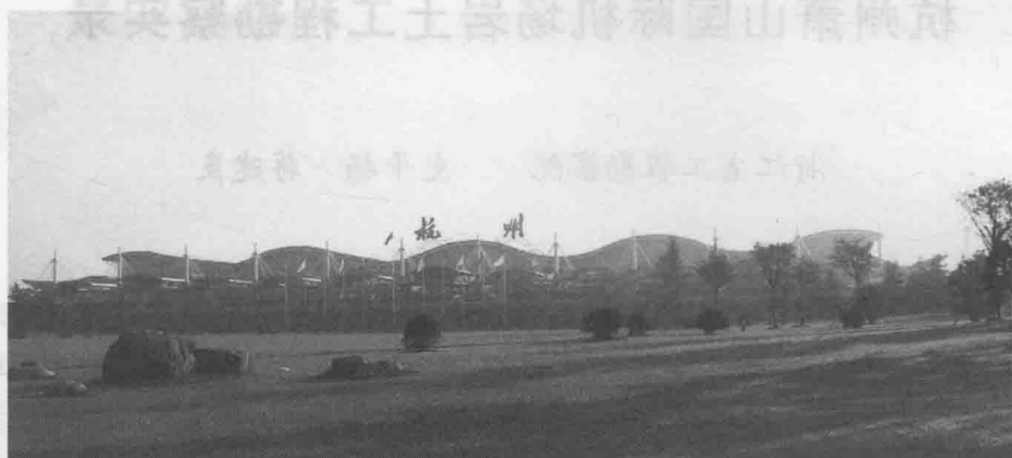
图 1-2 杭州萧山国际机场外景
