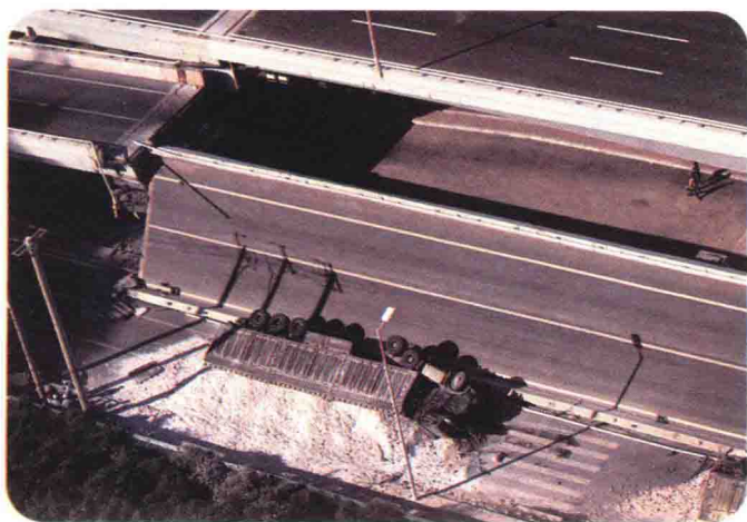
垮塌的阳明滩大桥引桥
