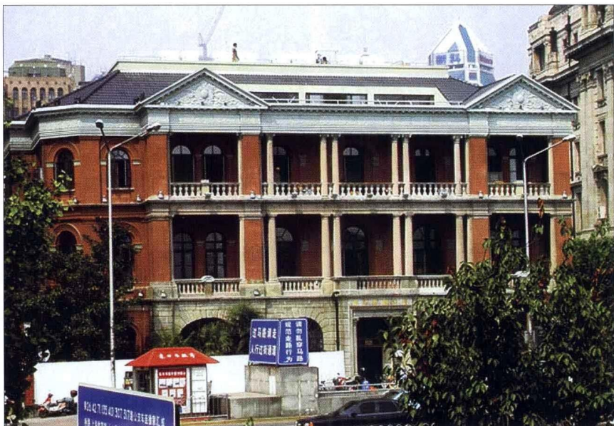
21世纪初的（上海）招商局大楼
