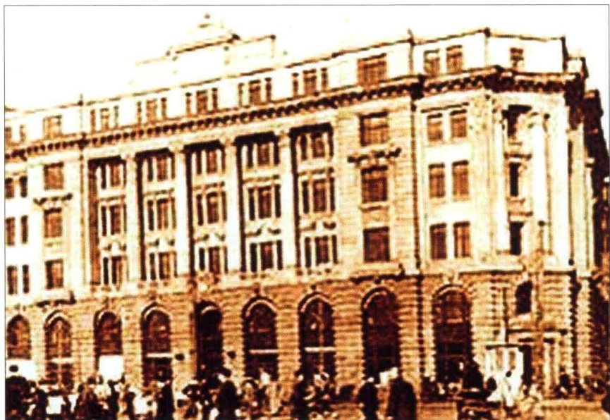
上海怡和洋行大楼
