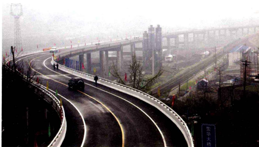
建成后的董华大桥
