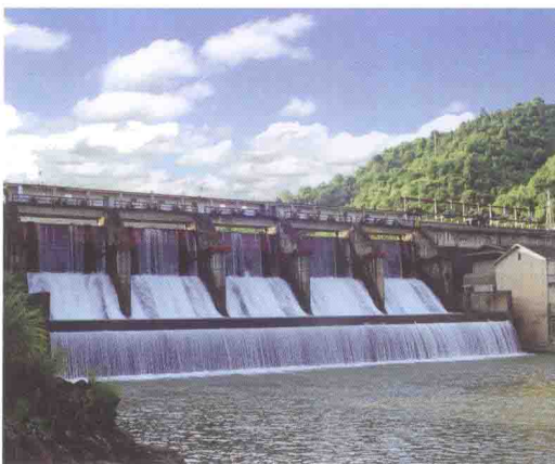
嵩口电站大坝
