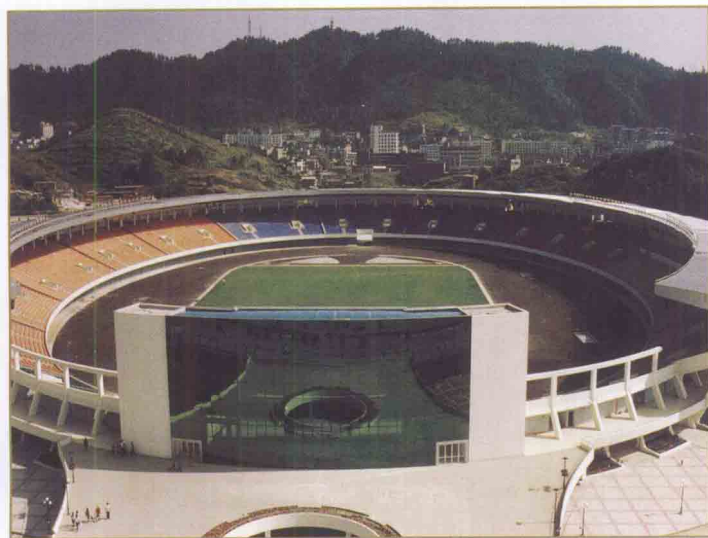
遵义汇川体育中心体育场
