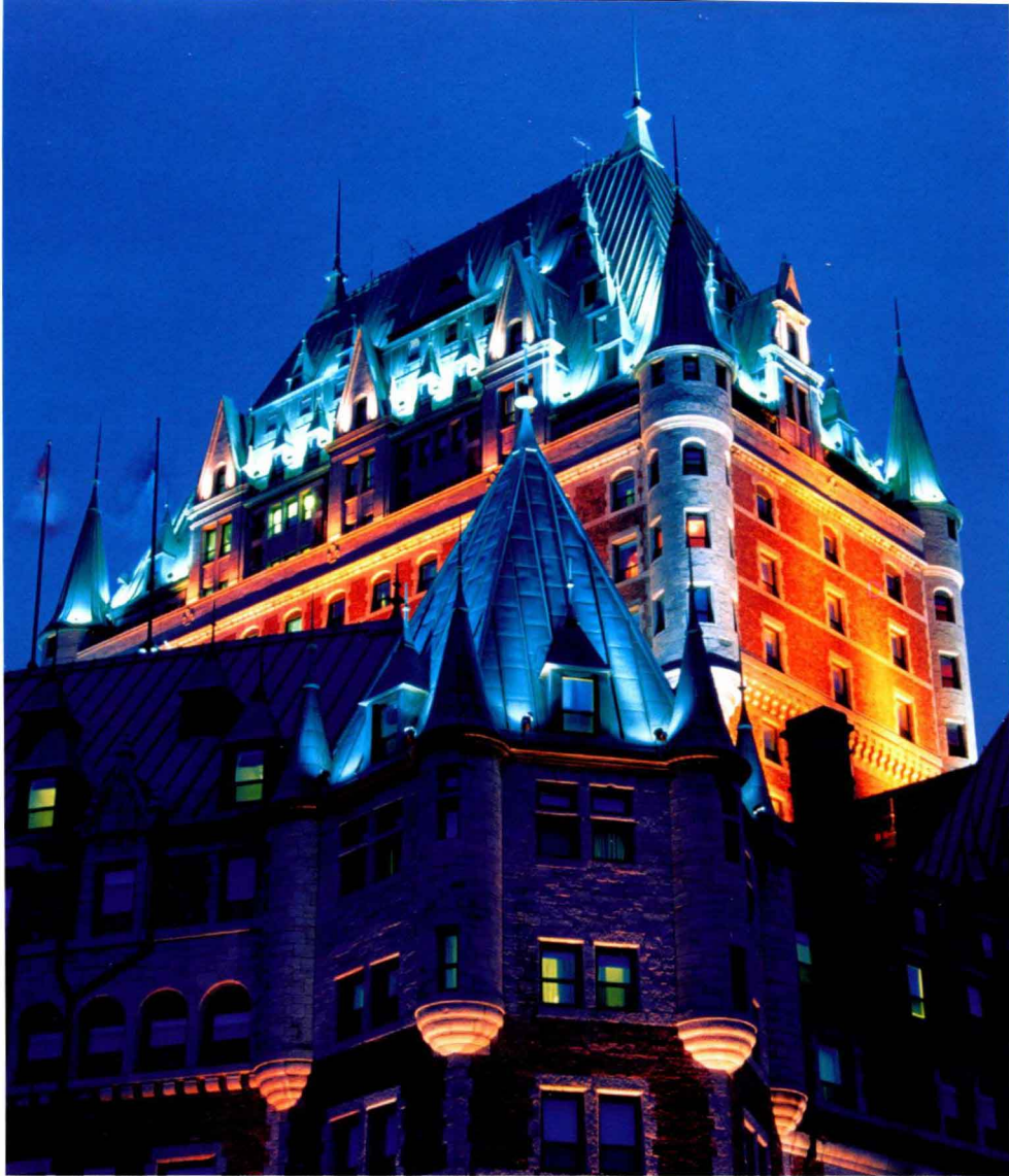
这座位于魁北克圣劳伦斯河码头上的芳提纳克城堡酒店（Château Frontenac）建筑风格明显受到法国文化的影响。
