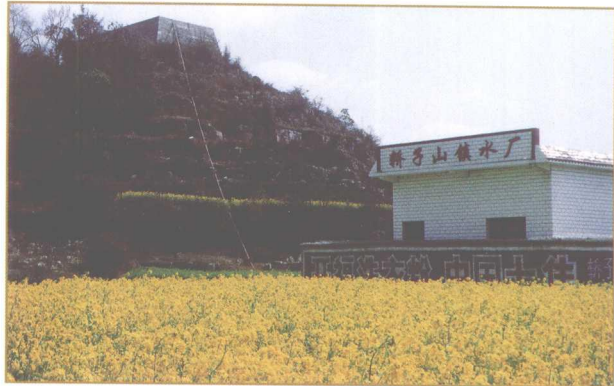
2002年5月，轿子山镇水厂竣工投入使用。
