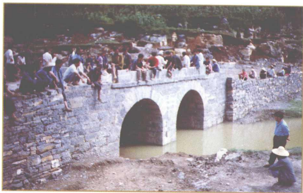
1995年10月，轿子山镇袁家屯至屯脚路段干峰河桥竣工。
