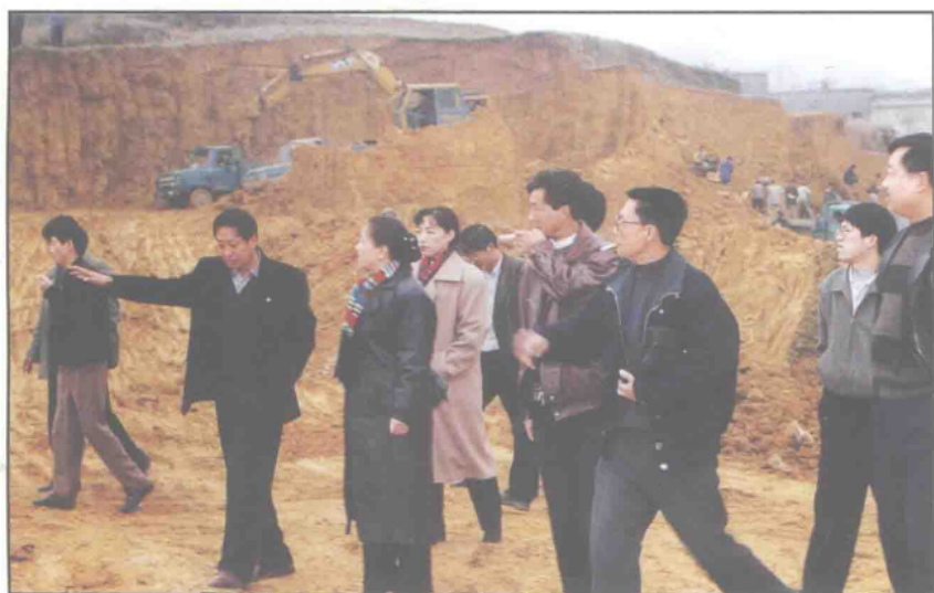
国家粮食储备局 张建荣处长(左三)到 二铺中直粮库工地指 导工作。
