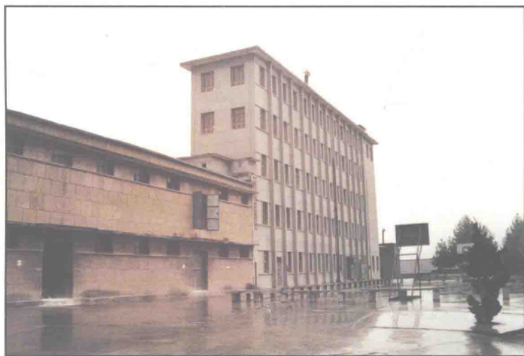
毕节市粮食局面粉厂面粉生产车间。
