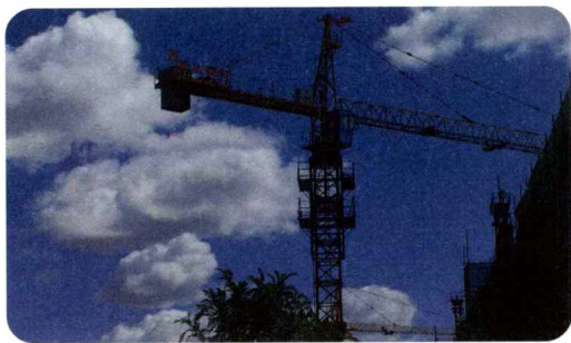
建设中的小城——内蒙古自治区乌海市
