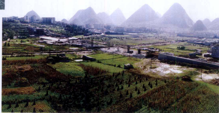
在建中的白鹤高架桥 (2007年)
