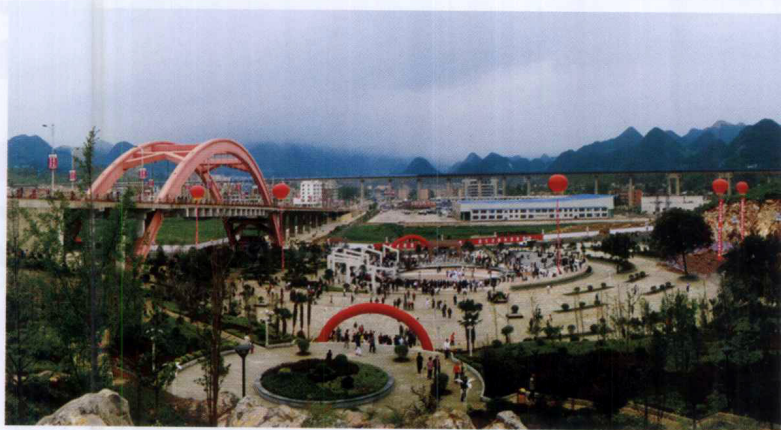
建成的白鹤高架桥 (2007年)
