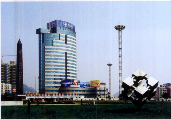
六盘水市人民广场电信大楼(2007年)
