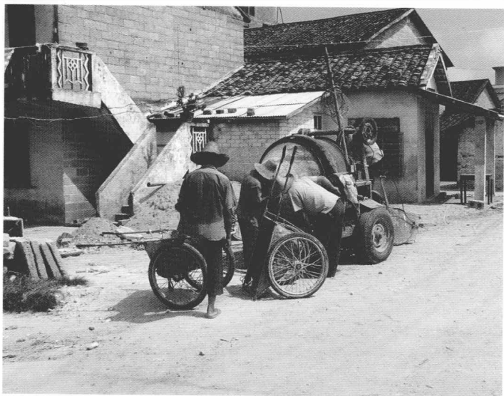
建筑队在施工
